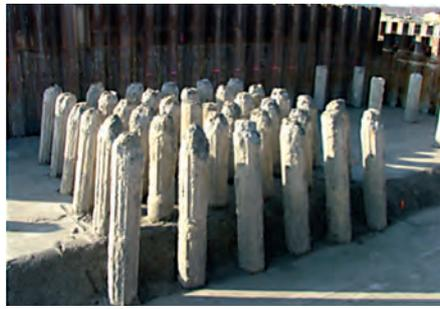
Abb. 9: Pfahlanordnung in der Planungsphase lässt hydraulisches Kappen nicht zu (Foto: Franki)
