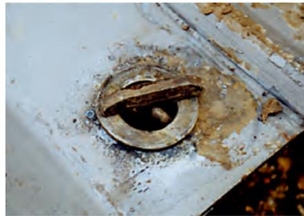
Abb. 3: Knebelkette mit Unterlegscheibe  $\varnothing$  40 mm auf gebranntem Loch
