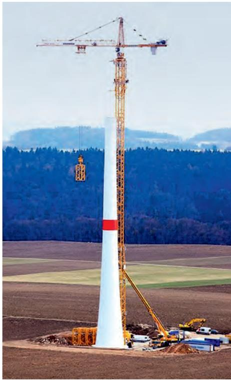
Abb. 9a und b: Montage der Gondel bzw. des Turms einer Windkraftanlage mittels eines Raupenkrans bzw. eines Turmdrehkrans (Quelle: Firmengruppe Max Bögl)
