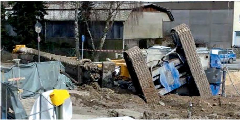
Abb. 7: Bei der Ausführung einer Dichtwand kam es 2016 in Bremen zum Umsturz eines MIP-Gerätes RG 25 (Quelle: BAUER Spezialtiefbau GmbH)
