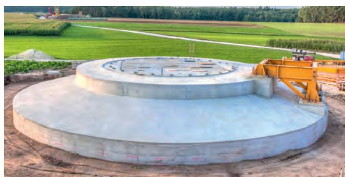
Abb. 6: Fundament einer Onshore-Windkraftanlage (Quelle: Firmengruppe Max Bögl/Herbert Stolz)
