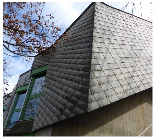
Abb. 1: Fassade aus Asbestzement
