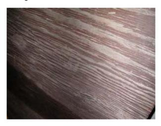
Abb. 2: Holz im Außenbereich mit abgewitterter Holzschutzfarbe
