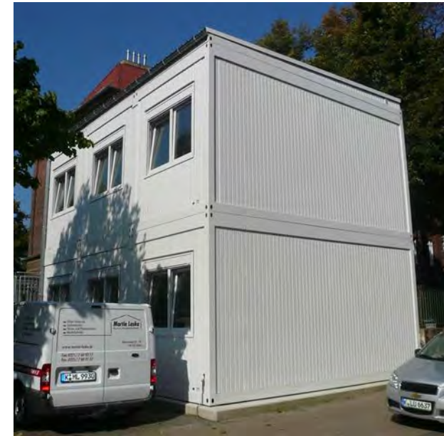
Containerbau für Schulklassen
