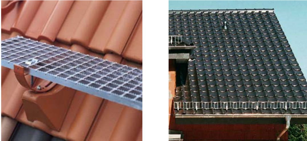
Abbildung 6.5-18: Trittrost für den Kaminfeger und Schneefanggitter
