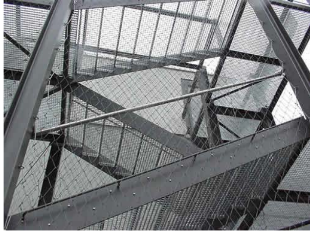
Abbildung 6.5-20: Spindeltreppe mit Gitterstufen und Treppenturm mit beschichtet Wangen und Stufen aus verzinktem Gitterrost
