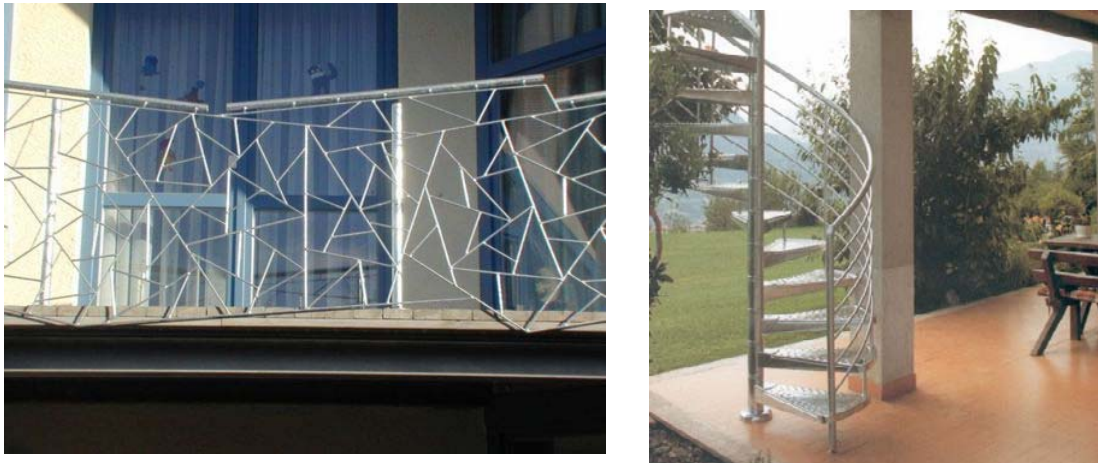
Abbildung 6.5-19: Beispiel für verzinktes Balkongitter und Edelstahlterrasse
