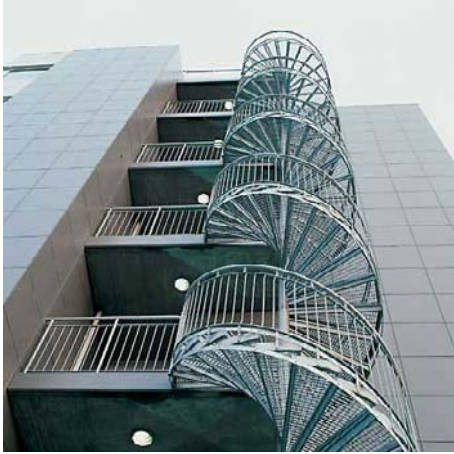
Abbildung 6.5-20: Spindeltreppe mit Gitterstufen und Treppenturm mit beschichtet Wangen und Stufen aus verzinktem Gitterrost
