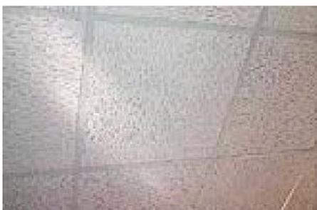
Abb. 2: Deckenplatten aus KMF, Relief „Odenwald“
