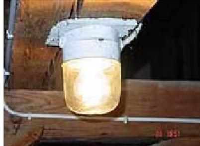
Abb. 4: Asbestpappe über Kellerlampe,
