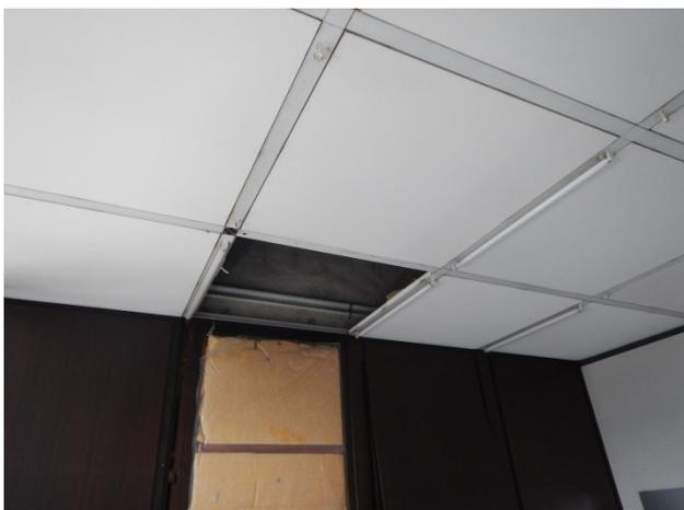
Abb. 1: PCB-haltige Deckenplatten Typ „Wilhelmi“
