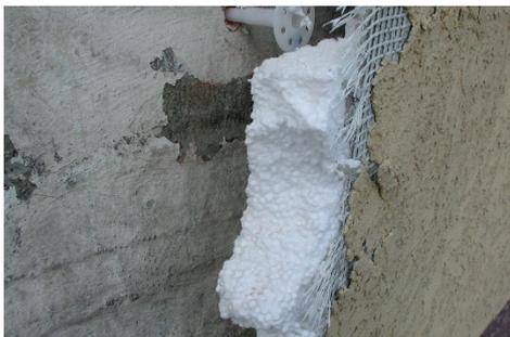
Abb. 1: Polystyrol-Dämmstoff in einem Wärmeverbundsystem
