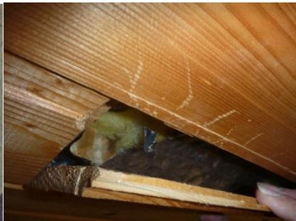
Abb. 2: Mineralwoll-Isolierung hinter einer Profilholzdecke
